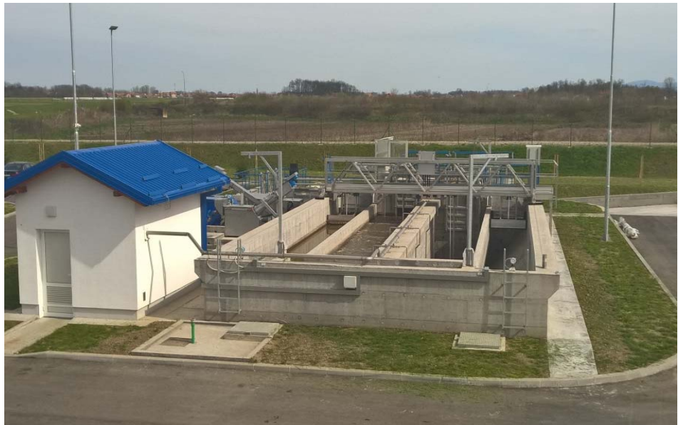
Prétraitement - Dégrilleur et déssableur
