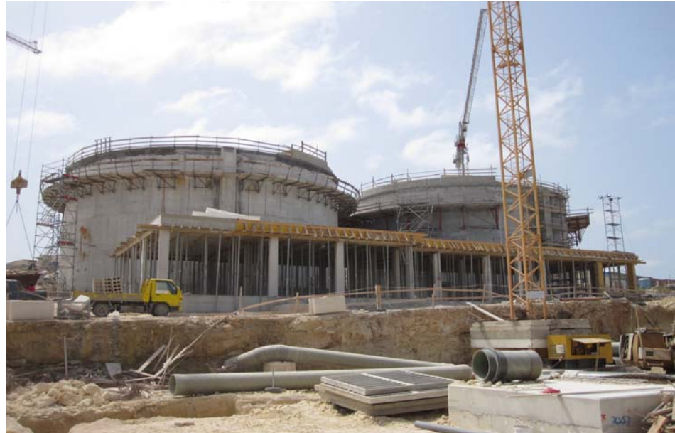
Digesteurs en Construction
