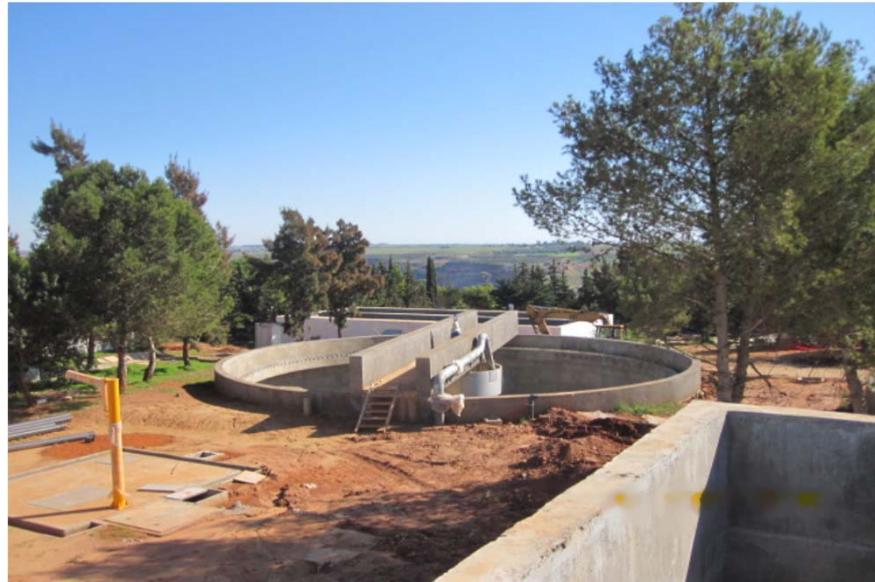
Clarificateur en construction, Station Bouregreg à Rabat
