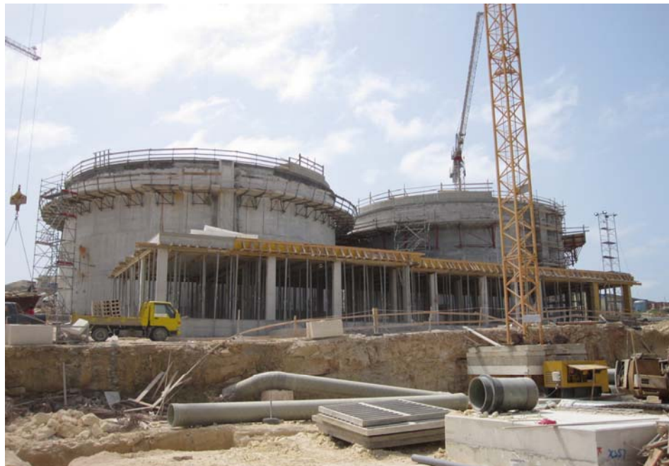
Bau der Faultürme
