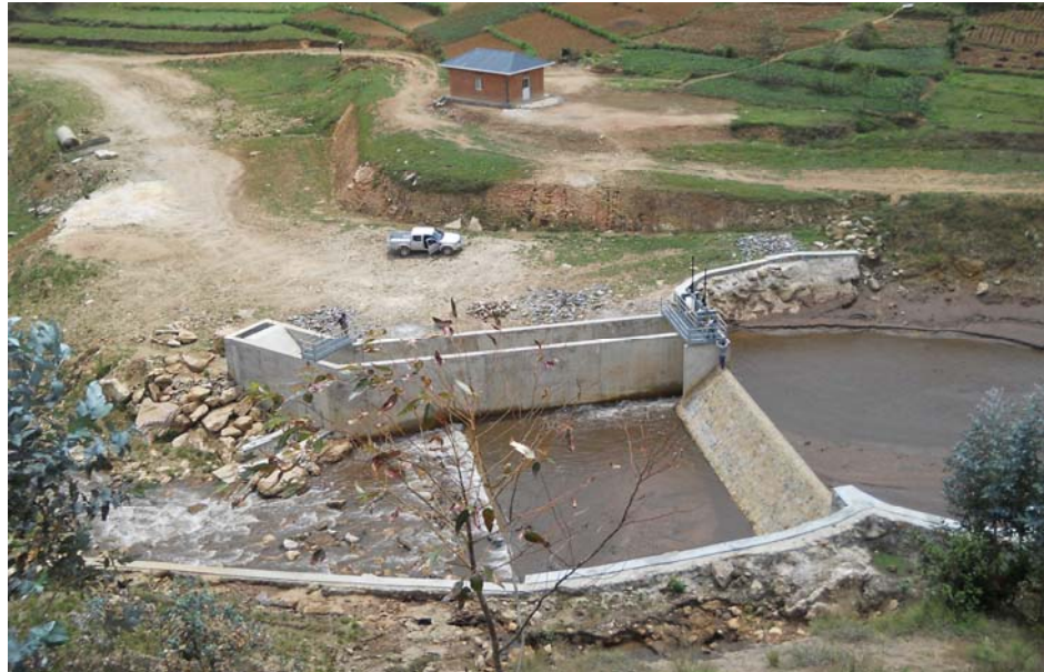
Beispiel eines Einlaufbauwerks
